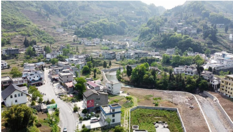
污水处理厂西面现状柴家井村
