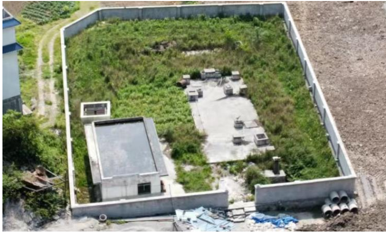
污水处理厂现状
