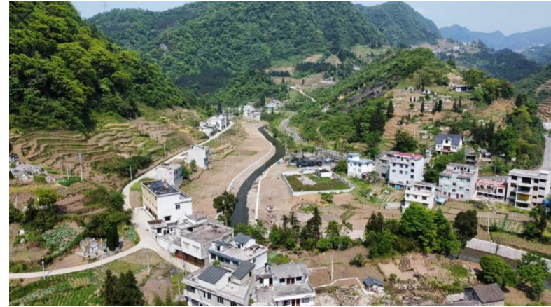
污水处理厂南面和东面现状柴家井村
