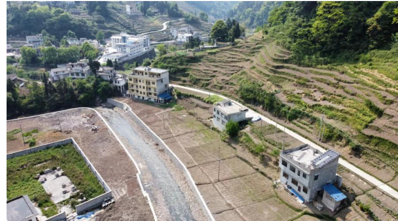
污水处理厂北面现状柴家井村
